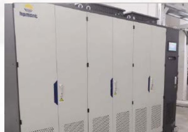
广东 8m/s 电梯 试验塔项目 8m/s High Speed Elevator Test Tower Project
